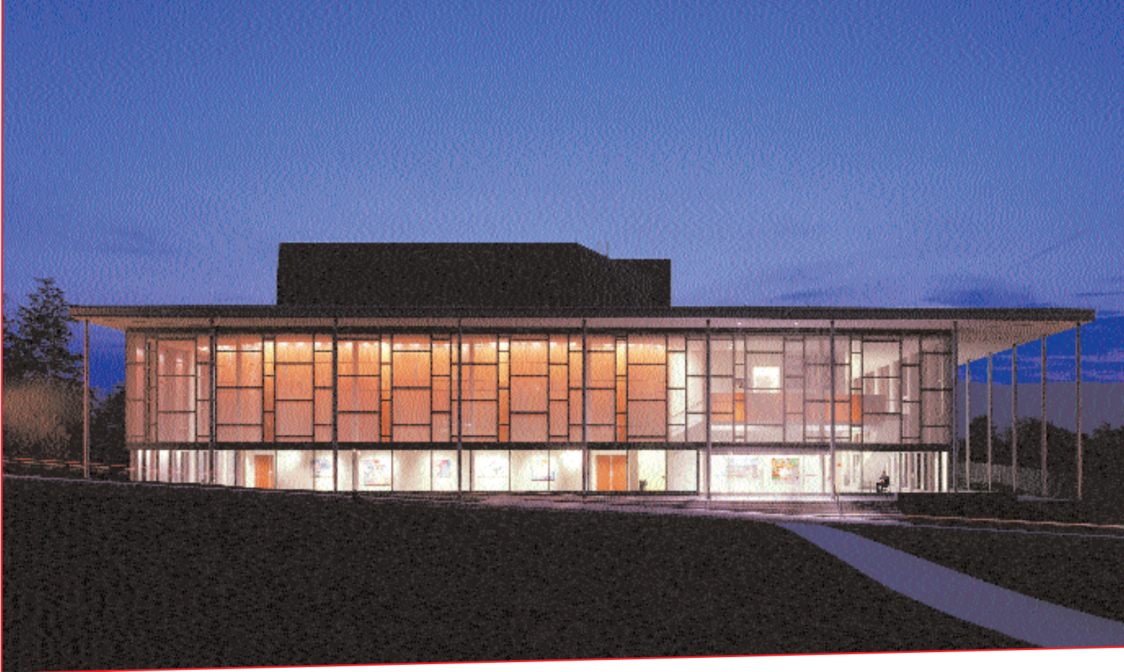
Todd Schliemann – Centrum umění Burgin / Burgin Centre for the Arts
